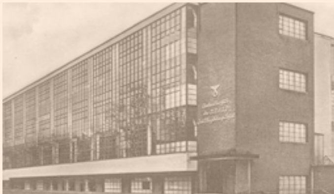
Bild: Walter Gropius (Architekt): Bauhausgebäude Dessau (1926) als Gauführerschule der NSDAP (1937), © Klassik Stiftung Weimar
